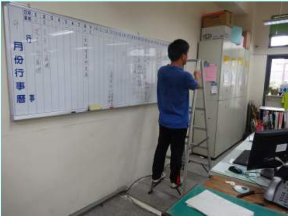
模擬受傷勞工使用合梯情形(當時陳○○為安裝吊掛白板之螺栓)
